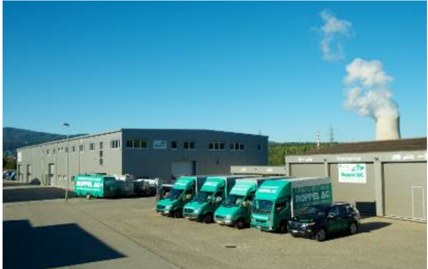
Bildlegende: Am Sitz der Firma Roppel in Obergösgen setzt man für die Beheizung des 15 000 Kubikmeter grossen Betriebs- und Gewerbehuses auf die Ölheizung. (Quelle: Roppel AG)
